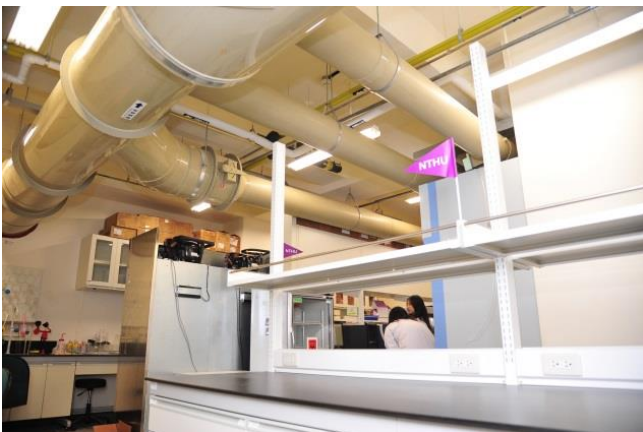
清華實驗室統一建置廢氣排放管線。
