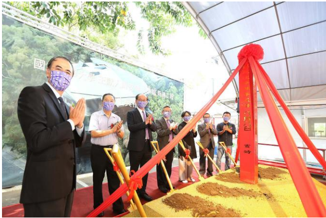
貴賓們持金鏟完成動土儀式
